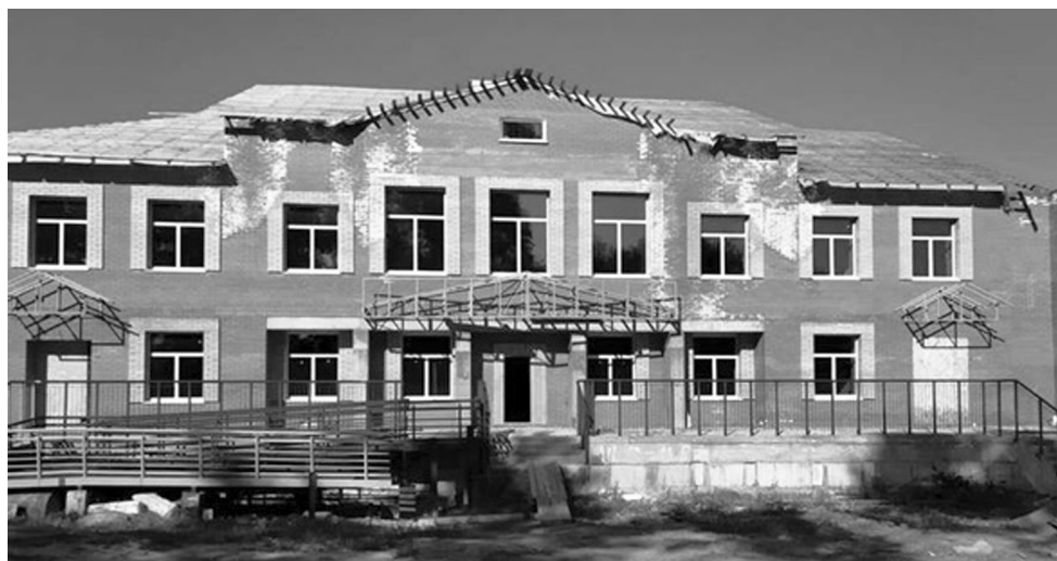
Строительство детского сада на 80 мест в селе Новокурск практически сразу началось с проблем. Летом 2020 года выяснилось, что подрядчик испытывает большие трудности с квалифицированными кадрами
